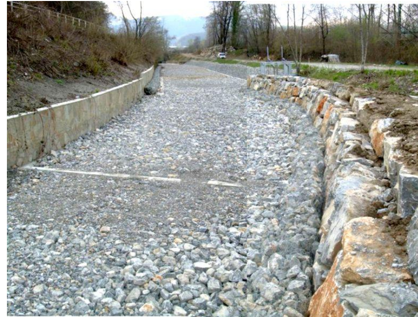
Opera di presa, rivestimento del fondo con scampoli di pietra rinforzate.
