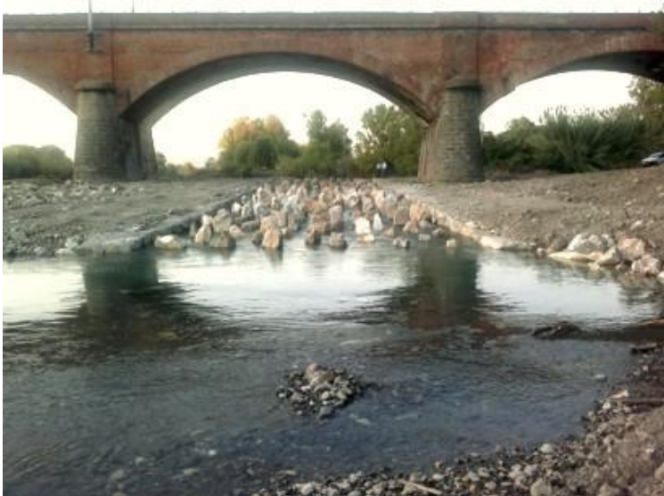
Fiume Magra: realizzazione di passaggi naturalistici realizzati con tecnica fisch ramp e pool type .
