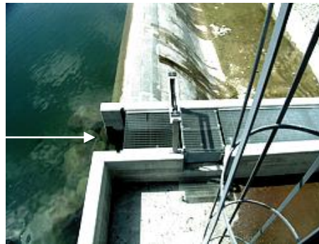
Uscita, verso monte, della scala di risalita lungo lo sbarramento
