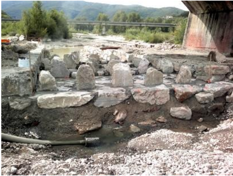
Fiume Magra: realizzazione di passaggi naturalistici realizzati con tecnica fisch ramp e pool type .
